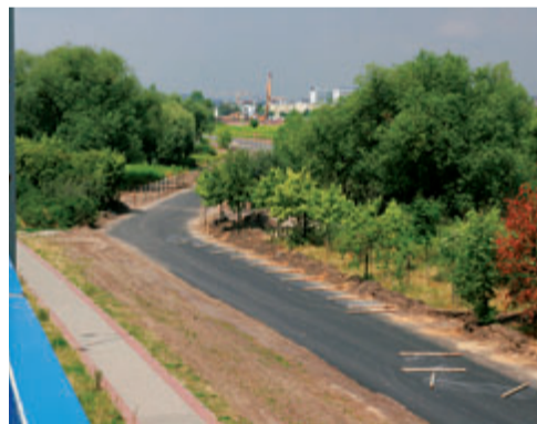
Zdj. Droga robocza do obsługi budowy galerii Poznania – widok z estakady katowickiej – czy droga dojazdowa dla klientów galerii nie może w przyszłości przebiegać właśnie wtedy zamiast pod oknami bloków?
