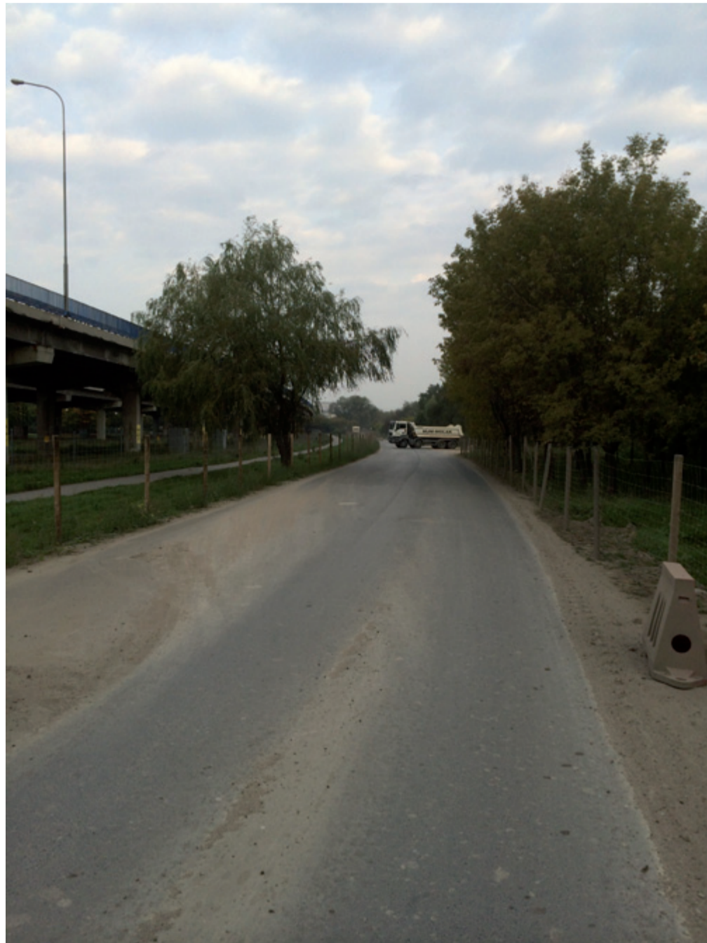
Zdj. Asfaltowa droga robocza do obsługi budowy galerii handlowej.
