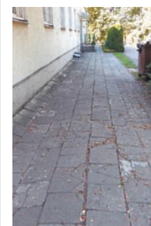
przed remontem fot. Artur Gumny
